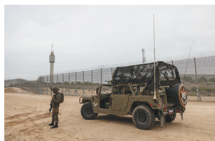
12月7日,士兵在以色列沿加沙地带“智能”隔离墙完工仪式上警戒。以色列国防部7日宣布,经过3年多施工,沿巴勒斯坦加沙地带的“智能”隔离墙修建完成。该“智能”隔离墙全长65公里,分为地上和地下两部分,沿隔离墙安装有数百个摄像头、雷达系统和传感设备。新华社发
