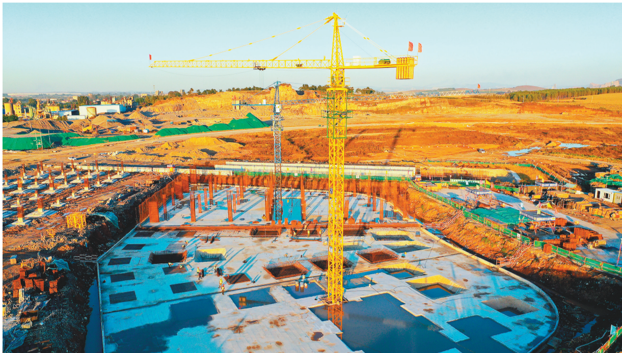
欧洲智能制造产业园项目正加紧进行基础设施建设。
