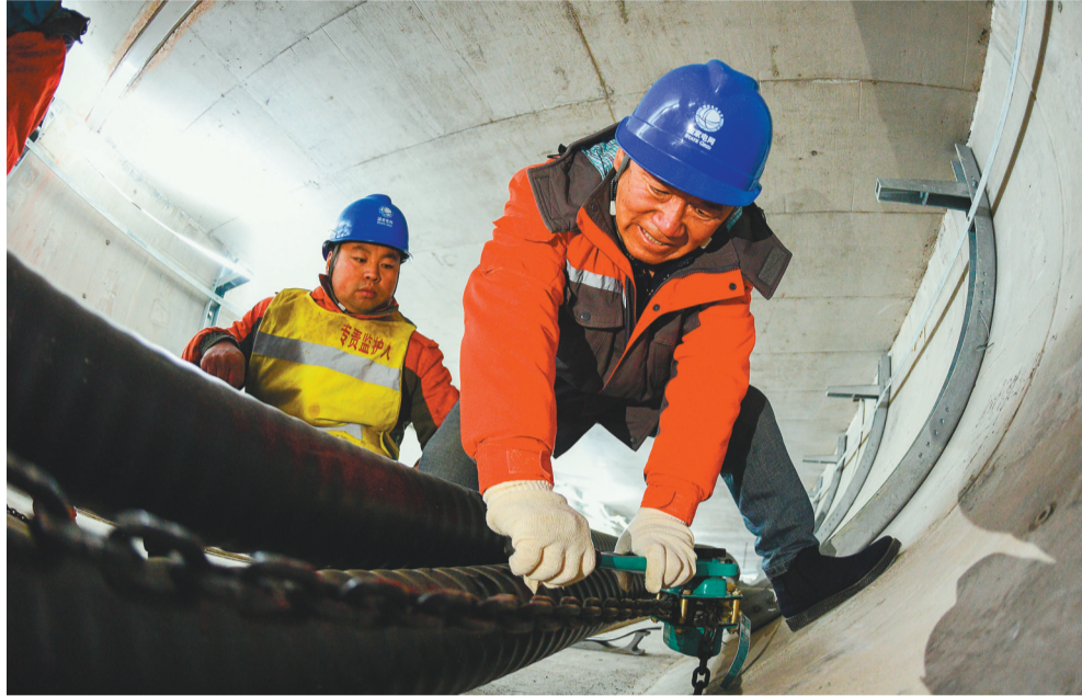
220千伏盛京-湾江电缆线路工程施工人员在第三区间牵引电缆。
