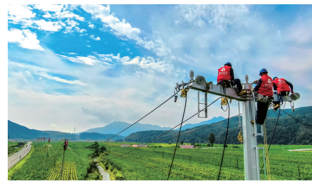
供电技术骨干对庄河三架山线进行施工。
