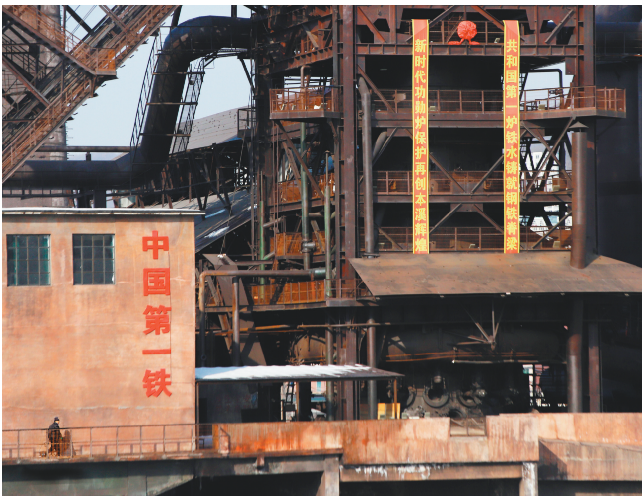
正在修复和建设中的本溪湖工业遗址博览园。
