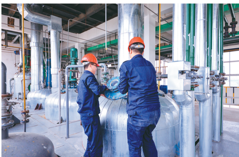
在辽宁鸿昊的生产车间内,技术人员正在维护化学反应釜。
