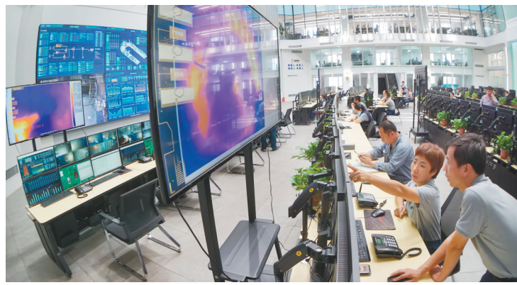
通过抚顺新钢铁有限责任公司智控中心操控平台,可以看到各岗位运行数据。
