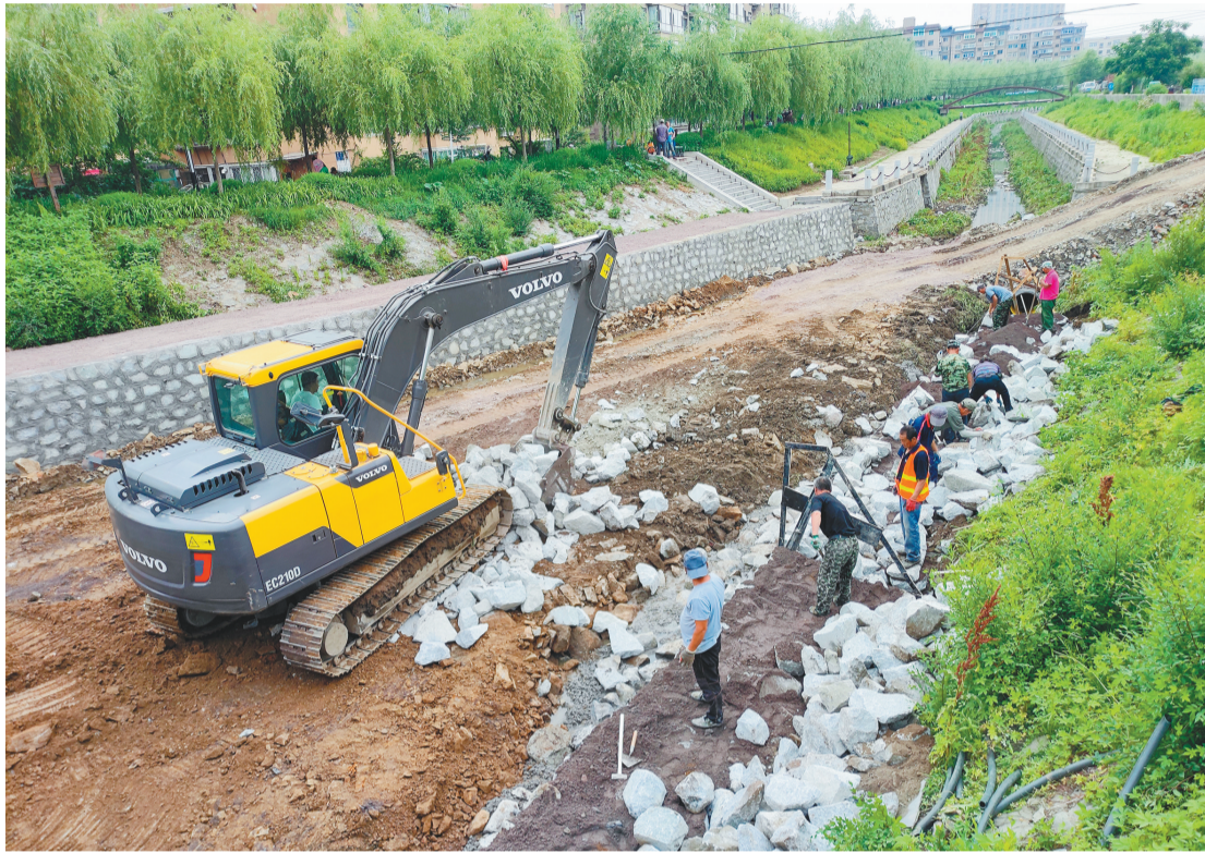
城市内河五道河护坡修复施工现场。
