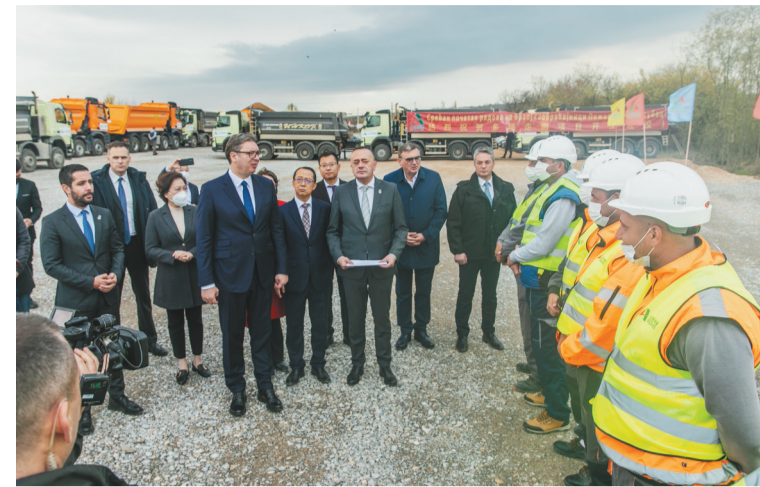
11月5日,在塞尔维亚东部城市波扎雷瓦茨,塞尔维亚总统武契奇(中左)出席中企承建的“多瑙走廊”项目开工仪式。当日,由中国山东高速集团承建的塞尔维亚“多瑙走廊”快速路项目在波扎雷瓦茨举行开工仪式,塞尔维亚总统武契奇、中国驻塞大使陈波等出席开工仪式。 新华社发
