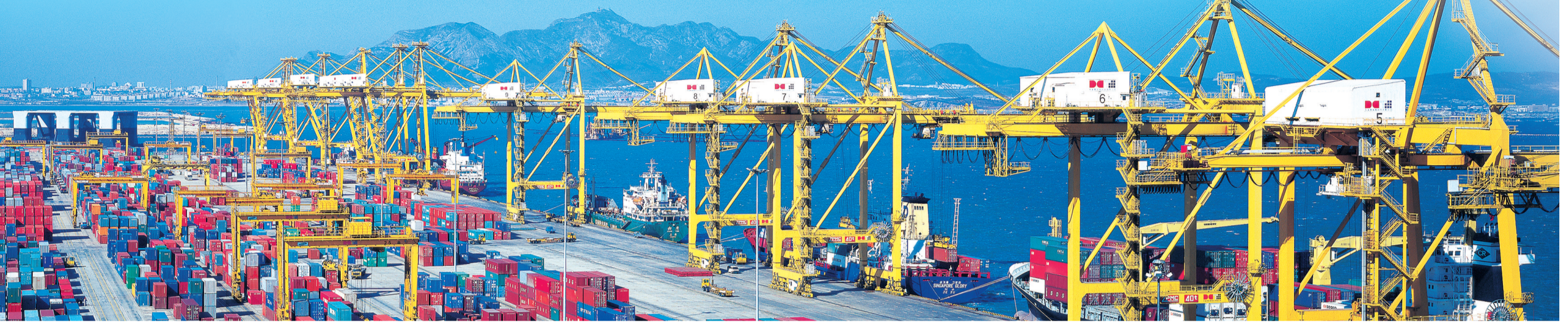
繁忙的辽宁港口集团大窑湾集装箱码头。
