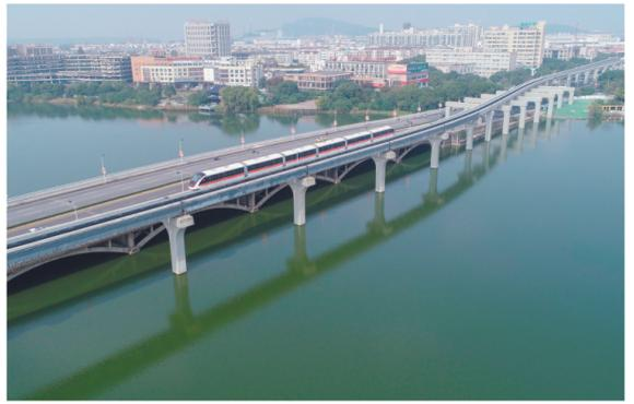
11月3日,芜湖市无人驾驶跨座式单轨列车在行驶中(无人机照片)。当日,安徽省芜湖市轨道交通1号线开通运营。该线路是一条无人驾驶跨座式单轨,全长约30公里,沿城市南北向铺设,设高架站25座,设计时速80公里。
