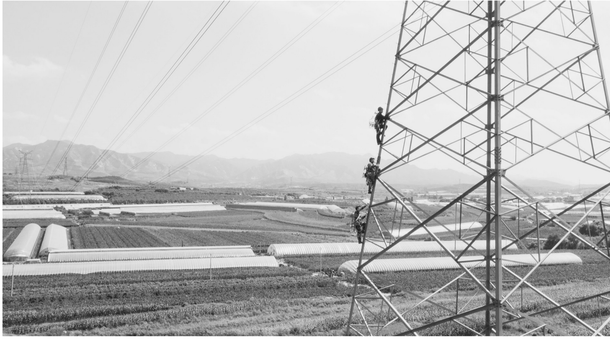
国网营口供电公司员工在220千伏海仙线开展线路检修维护,保障营口市用电需求。 苑伟伟 摄
