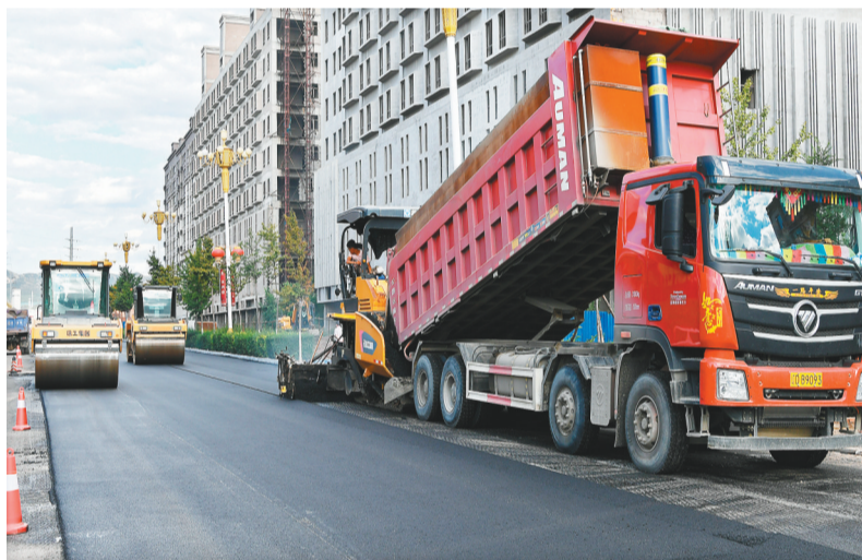
北票市对城区主次干道进行维修,翻新主路面15万平方米。 本报特约记者 仇一军 摄
