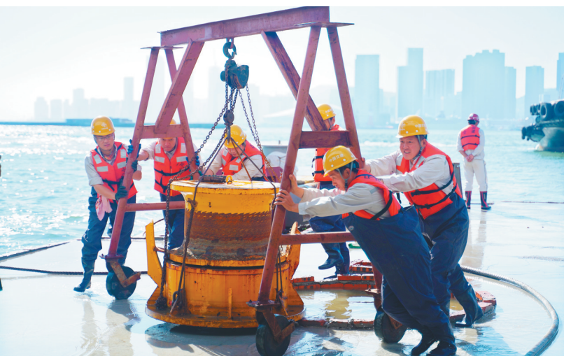
大连湾海底隧道项目E9管节安装现场。
