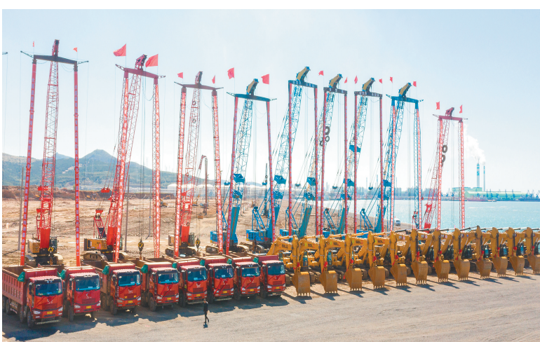
恒力45万吨/年可降解新材料及配套产业项目开工现场。
