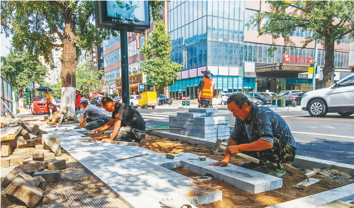
施工人员正在铺设七经街人行道路面。
