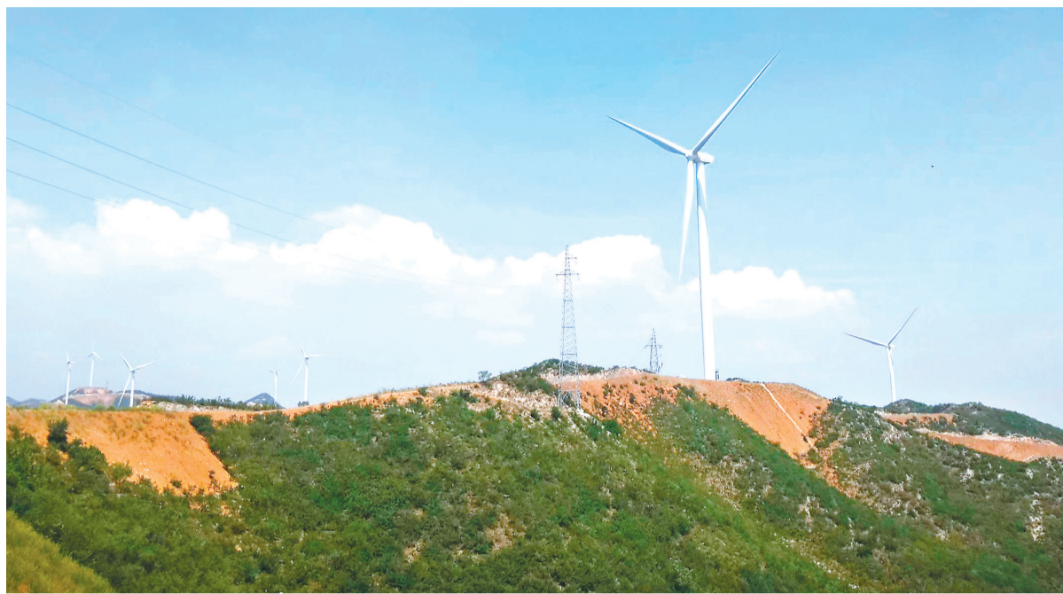
朝阳天润杨树湾风电场项目。
