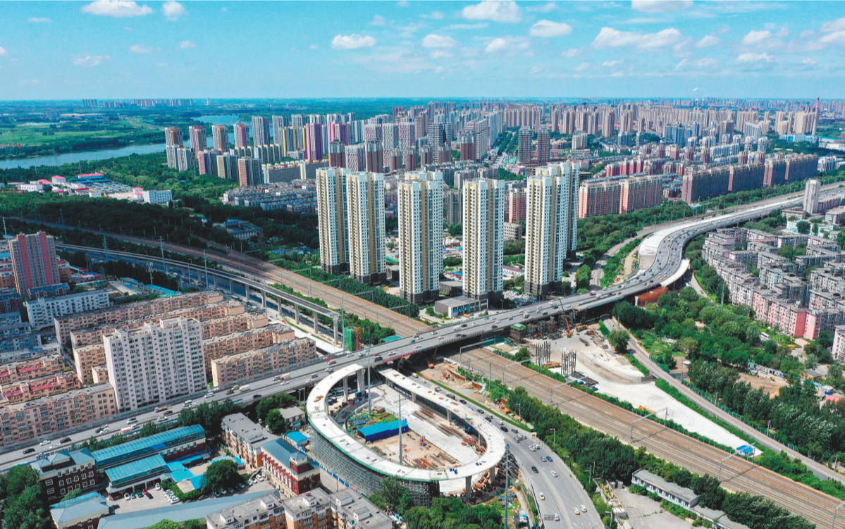
图为7月16日,航拍沈阳市胜利大街揽军路跨铁路转体桥工程现场。据悉,该转体桥工程连续跨越6条铁路线路,建成后将连接新老二环,将沈阳西部大部分车流导入新南二环浑南大道快速路,有效缓解南二环的交通拥堵问题,优化城市路网结构。 本报记者 赵敬东 摄
