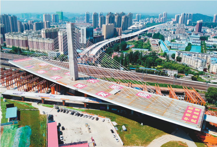
6月22日,由中铁大桥局承建的河南省信阳市跨京广铁路斜拉桥成功转体。转体主梁总长291米,总重量达1.96万吨。图为跨京广铁路斜拉桥转体施工场景(无人机照片)。新华社发
