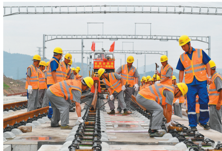
6月22日，中铁十一局的施工人员在杭绍台铁路上进行铺轨作业。当日，在杭绍台铁路温岭站施工现场，随着最后一根钢轨平稳在无砟道床上铺设到位，我国首条民营控股高铁杭绍台铁路全线铺轨贯通，为年底开通运营奠定基础。杭绍台铁路连接浙江杭州、绍兴和台州三地，线路设计时速350公里。
