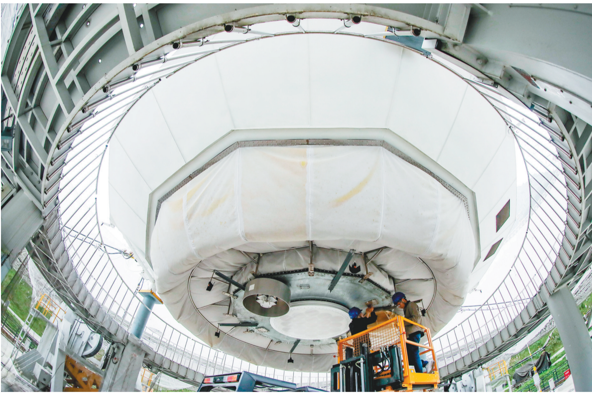
3月28日,工作人员对FAST馈源舱进行常规维护(鱼镜头拍摄)。当日,工作人员对“中国天眼”进行常规维护和保养,给“天眼”进行全面“体检”,保障“中国天眼”运行安全。被誉为“中国天眼”的500米口径球面射电望远镜(FAST)于2016年9月25日落成启用,2020年1月11日通过国家验收正式开放运行。目前,“中国天眼”是全球最大且最灵敏的射电望远镜,综合性能全球领先,极大拓展了人类观测宇宙视野的极限。 新华社记者 欧东衢 摄
