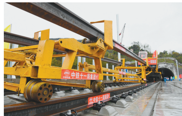
3月1日,在郑万高铁重庆段施工现场,铺轨机进行铺轨前的准备工作。当日,随着第一组500米长钢轨输入无砟轨道,由中铁十一局负责的郑万高铁重庆段铺轨工程正式启动。 新华社记者 唐奕 摄
