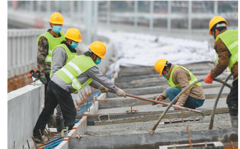
2月17日，杭绍台铁路中铁三局参建工人在位于浙江绍兴上虞区境内的绍兴特大桥进行轨道底板浇筑施工。春节期间，5500余名参与建设我国首条民营控股高铁——杭绍台铁路的员工坚守岗位“就地过年”，工人们利用晴好天气奋战在工地上，稳步推进工程建设进度。杭绍台铁路连接浙江杭州、绍兴和台州三个设区市，线路设计时速350公里，预计今年年底具备开通运营条件。新华社记者 黄宗治 摄
