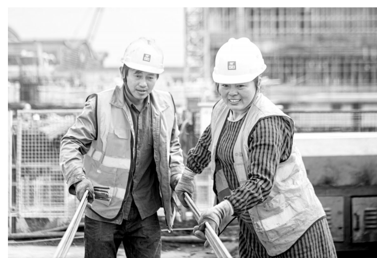
2月9日,在杭州萧山国际机场三期项目工地上,来自四川泸州的工人杨登平(左)、李瑞英在工作。春节临近,来自中建三局华东公司的630名工人和管理人员响应“就地过年”号召,留在杭州过年,同时保障杭州萧山国际机场三期项目交通中心工程建设正常有序进行。
