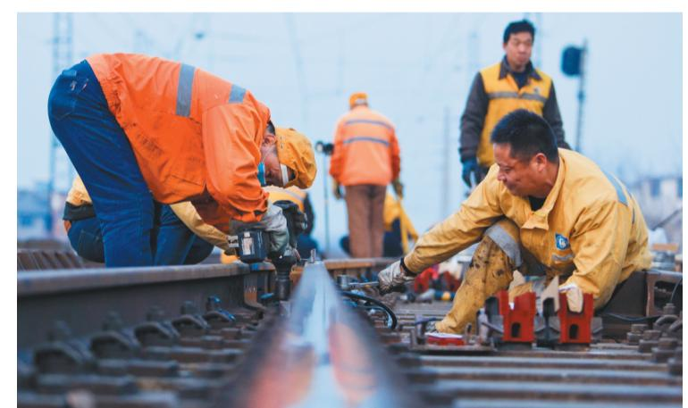
1月20日，中国铁路郑州局集团公司南阳工务段组织职工对焦（作）柳（州）铁路夏集站13号道岔的3个部位进行“接骨手术”，剔除重伤病心，恢复无缝线路，全力保障铁路线路畅通。图为工人对卡控轨端的部件进行固定。
