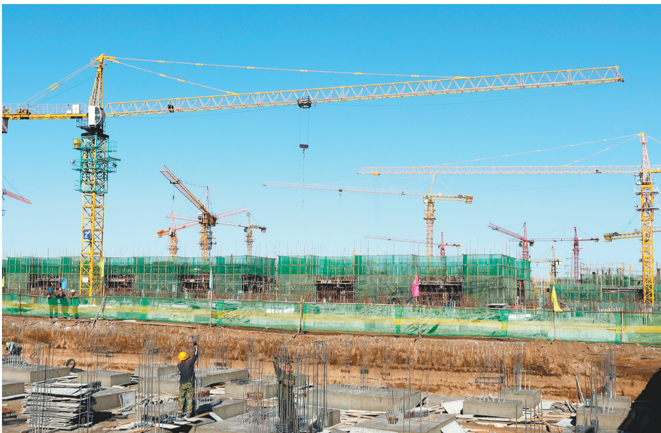
沈抚示范区冬季施工现场。
