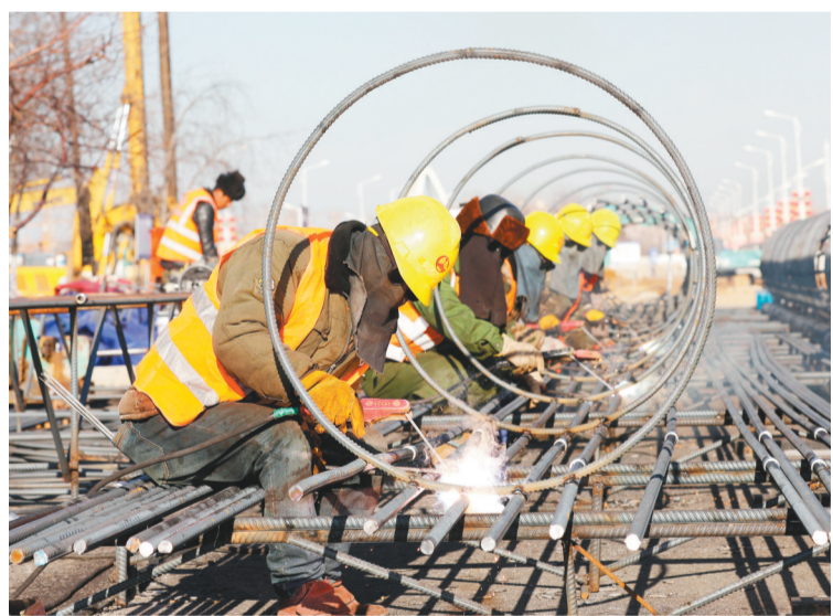
沈抚示范区小沙河生态整治项目现场。
