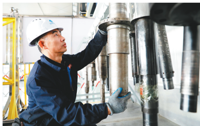
沈阳煤科院工作人员正在检查设备。
