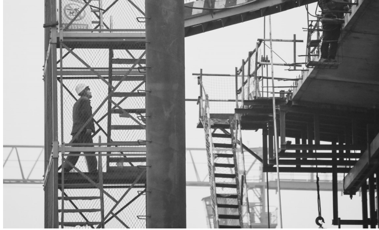
1月5日,中交三航局施工人员在沙洋县汉江二桥工程作业。目前,由中交三航局负责施工的湖北省沙洋县汉江二桥工程主墩全部出水,挂篮已全部安装完成。新华社记者 程敏 摄
