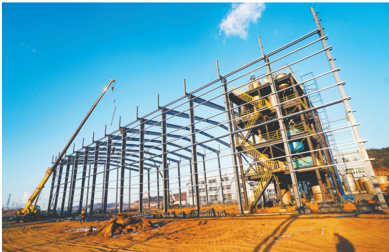
抚顺助剂项目建设现场。
