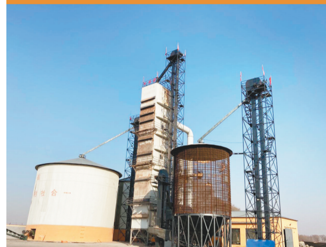
东兴村日烘干玉米300吨的烘干塔。
