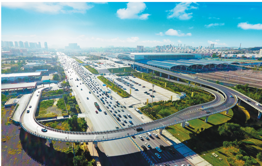
大连北站立交桥。
