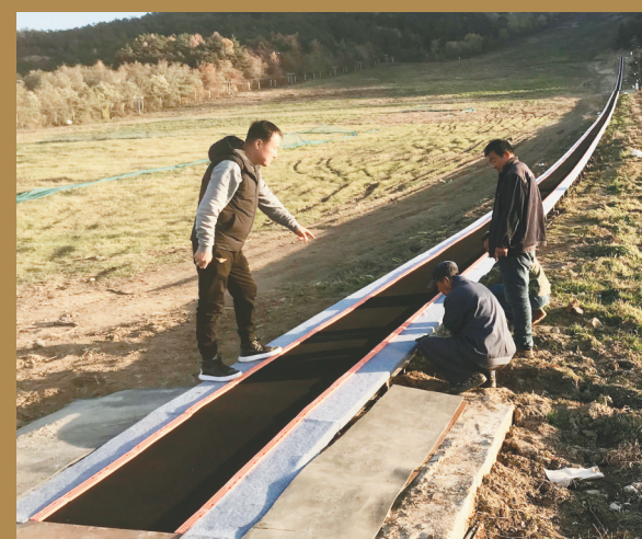
辽阳弓长岭温泉滑雪场综合雪道上,崔恩伟(左)和工人们一起查看新铺设的滑雪魔毯。
