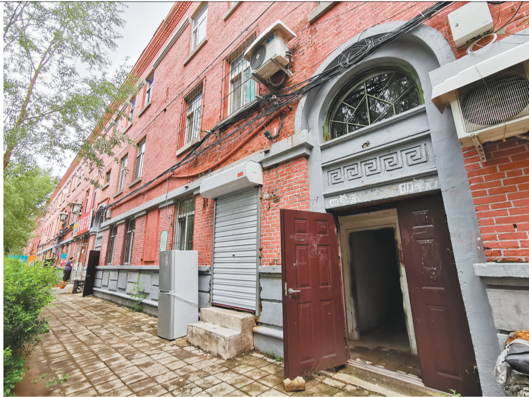
工人村住宅楼外景
