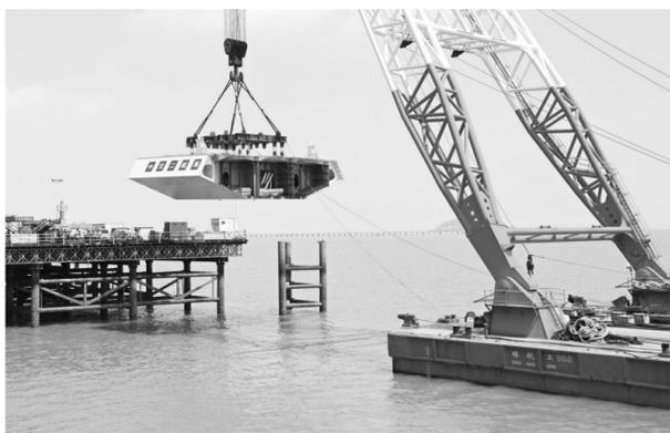
9月11日，一台700吨大型浮吊成功将313.9吨重的钢箱梁放置在塔区存梁支架上，标志着新建福建厦铁路泉州湾跨海大桥首榀钢箱梁吊装顺利完成，国内首座设计时速350公里的跨海高铁大桥主体施工正式进入钢箱梁、斜拉索安装阶段。
