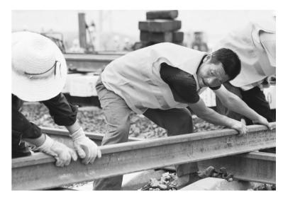
8月30日,中铁六局的施工人员在进行拨线作业。 当日,京沪线、京广线普速铁路正式拨入新建北京丰台站内。线路拨接完成后,开始进行丰台站北侧站房、旅客通道、行包地道等结构施工,为2021年底开通运营提供坚实保障。 新华社记者 张晨霖 摄
