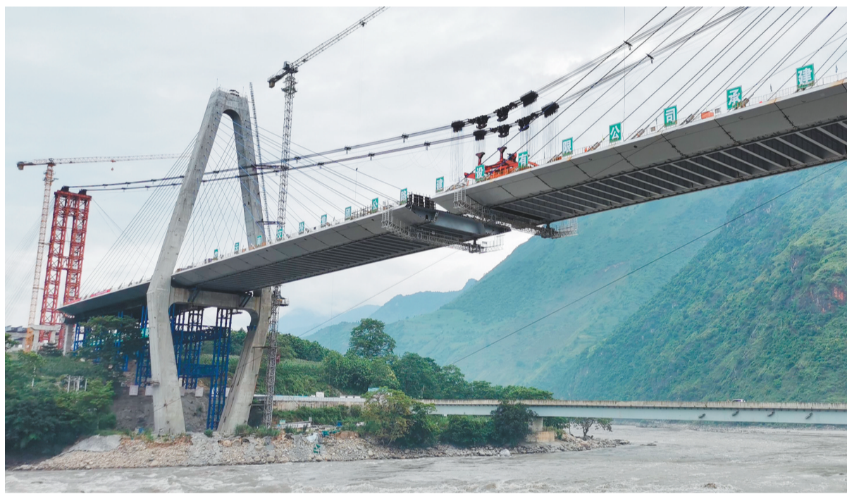
图为工人在云南保泸高速公路勐古怒江特大桥梁进行吊装作业。8月29日,云南保(山)泸(水)高速公路勐古怒江特大桥梁顺利合龙,为怒江傣族自治州首条高速公路的建成通车奠定了坚实基础。勐古怒江特大桥梁为云南保山至泸水高速公路的重点控制性工程之一,该桥跨越怒江,由主桥及两岸引桥组成,全长1333米。新华社发
