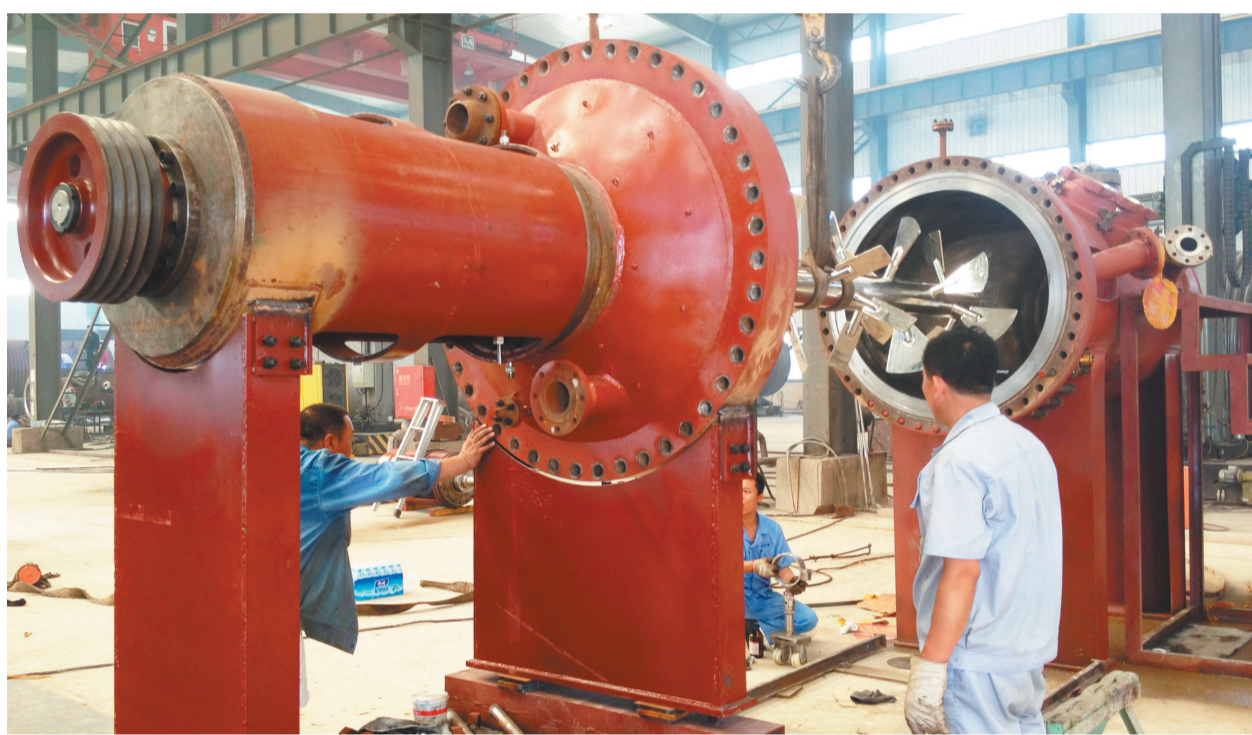
葫芦岛华远化工机械装备有限公司聚偏氟乙烯卧式釜正在组装中。
