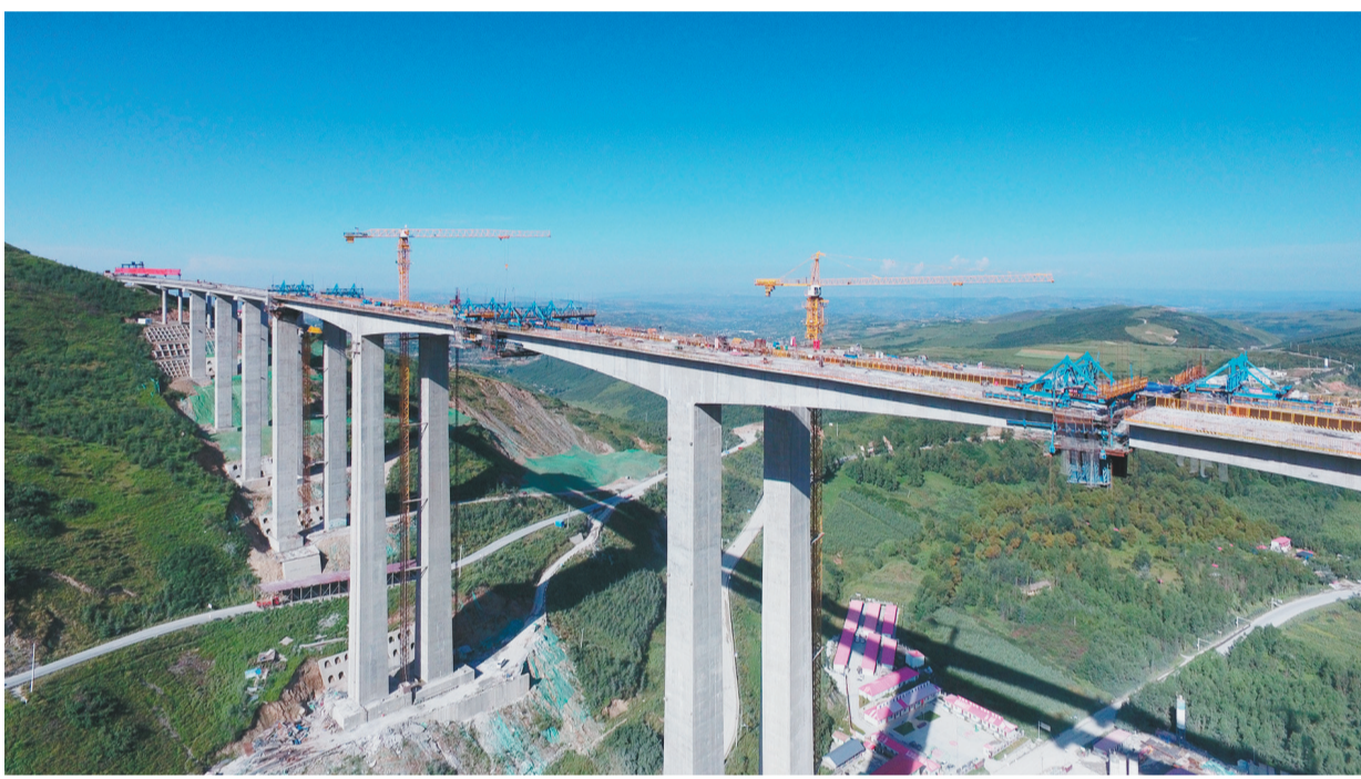
上图为双达公路卧龙岗3号特大桥建设现场(无人机照片)。
