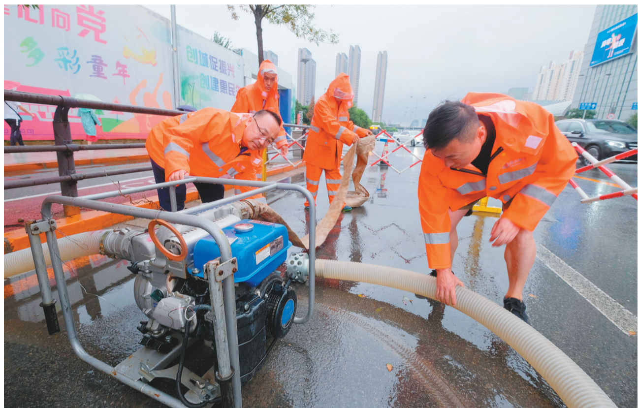
8月13日,沈阳水务排水集团南部管网分公司工作人员在易积水点位布置排水泵。
