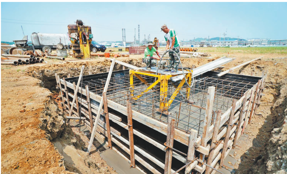
上药集团绿色原料药基地正在施工。
