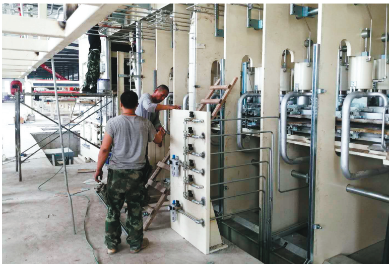
华实朝阳科技环保有限公司从德国引进的超薄密度板生产线正在安装。
