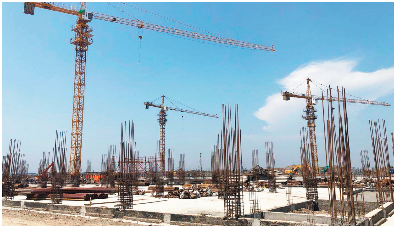
滨海新区化工产业园(B区)内项目正在抓紧建设生产。
