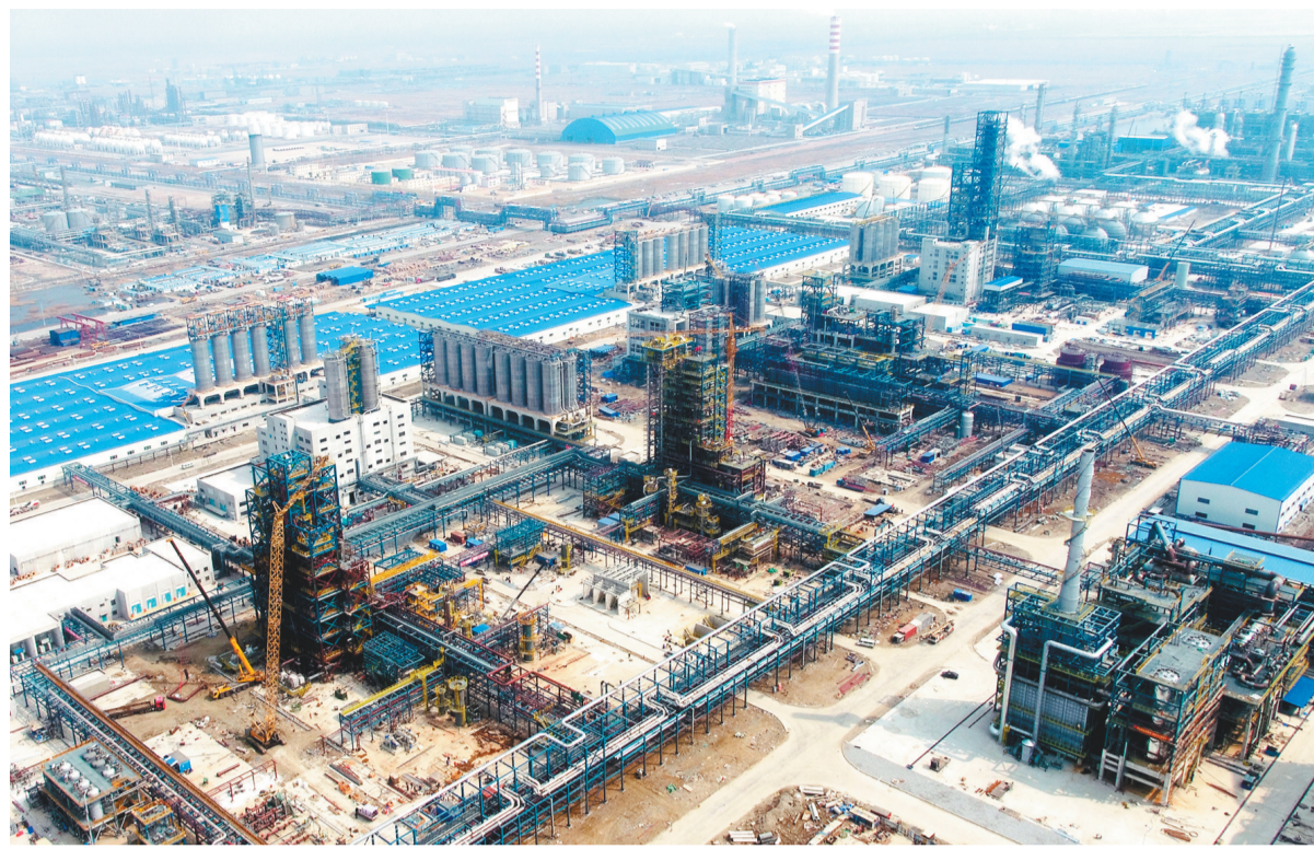
辽宁宝来轻烃综合利用项目一期工程施工忙。
