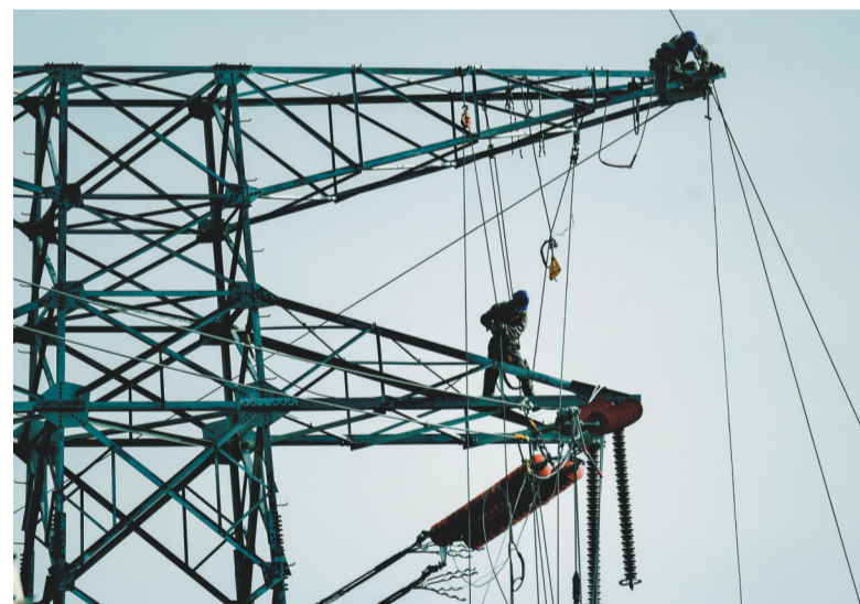
图为国网沈阳供电公司进行高负荷220千伏输电线路升级改造。
