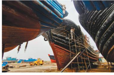
捻船是一种古老的修船方法。6月18日,盘锦市大洼区二界沟街道盘锦远航船厂,40余艘30多米长的木质机动渔船停放在船坞里,几十位捻匠正忙着修船。
