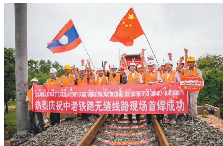
6月18日,在老挝首都万象北部,中国中铁二局员工庆祝中老铁路无缝线路现场首焊成功。中老铁路建设不断取得新进展。6月18日,中国中铁二局在老挝首都万象北部楠洪河桥头成功实现第一对长轨焊接,标志着中老铁路无缝线路现场焊接正式拉开序幕。
