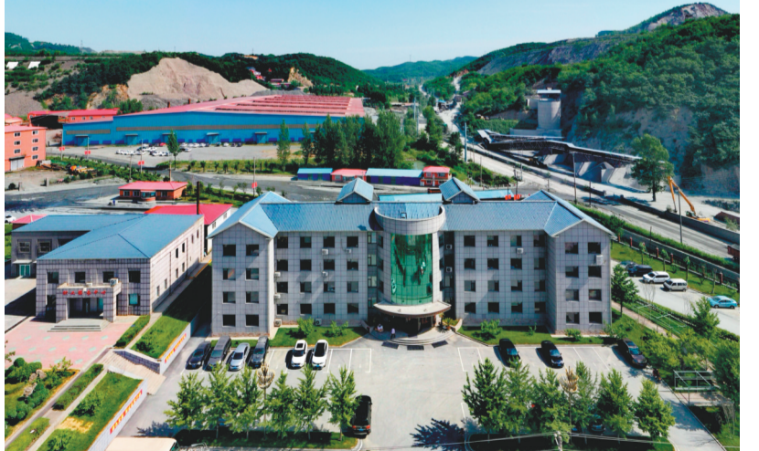
本溪矿业有限责任公司现代化办公楼外景。 于慧新 摄
