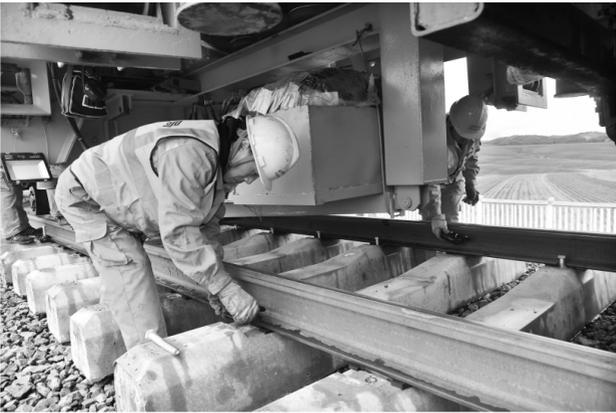
图为工人在位于黑龙江省牡丹江市林口县的牡佳客专铺轨施工现场劳作。6月15日,在黑龙江省林口县的牡(丹江)佳(木斯)客专高速铁路建设施工现场,随着铺轨机有序放下一根根枕木,首组500米长的钢轨一次性铺设成型,标志着牡佳客专正式进入铺轨施工阶段。
