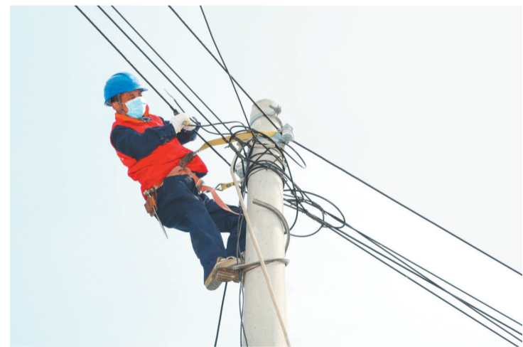
辽阳供电公司员工在庙沟村架设电线。
