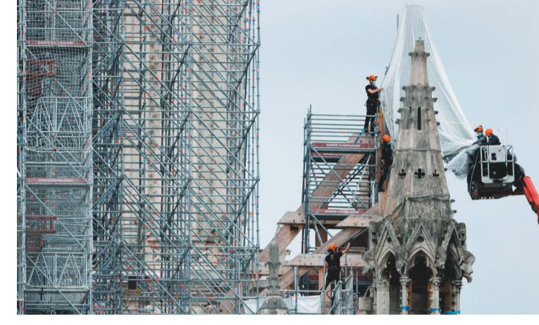
6月8日,工人拆除法国巴黎圣母院火灾中受损的脚手架。当日,修复工人开始拆除巴黎圣母院火灾中受损的脚手架。2019年4月15日,巴黎圣母院的屋顶和塔尖在突发大火中被烧毁,但主体建筑得以保存。新华社发
