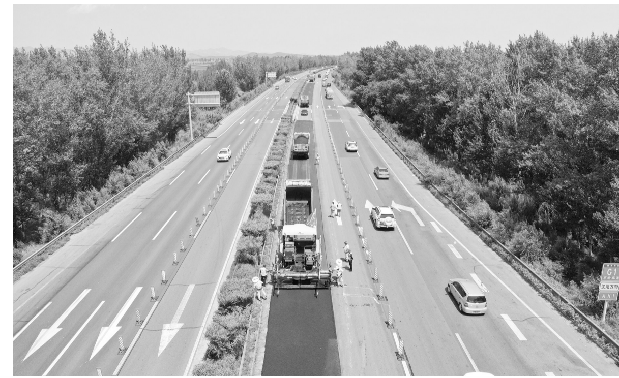
图为沈山线锦州段施工现场。
