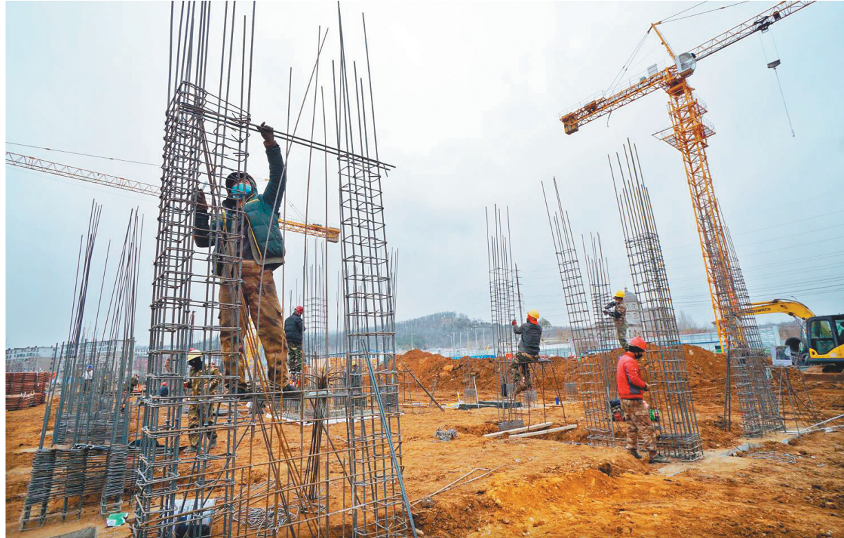
施工中的格林高品建设项目。
